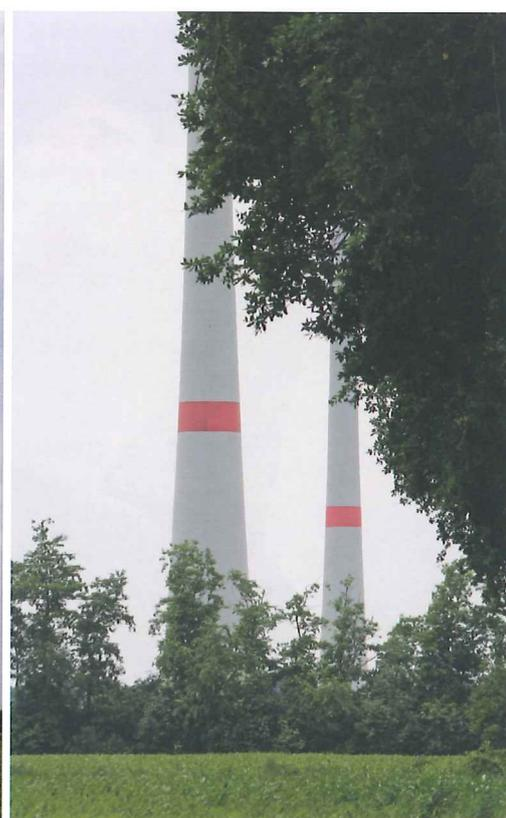
Windpark Scharrel im Landkreis Cloppenburg mit 24 ENERCON E-101/3 MW. Die Anlagen im Außenbereich wurden mit 135 Meter Nabenhöhe errichtet.
